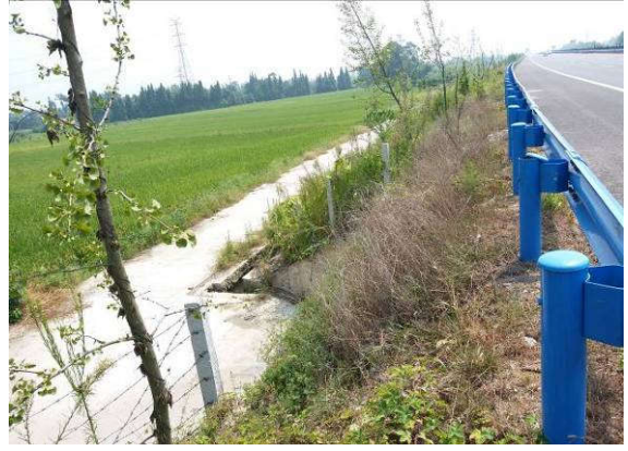
K8+000 施工便道
