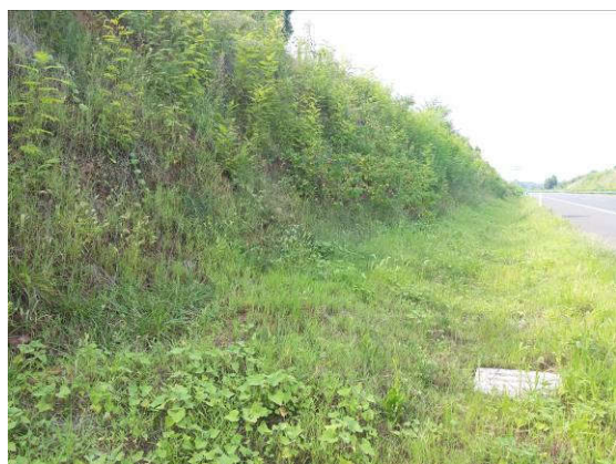
路面生态排水沟
