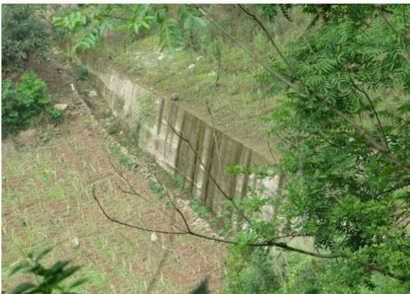
2#弃渣场坡脚挡墙、坡顶面复耕情况 (k46+900 右侧)
