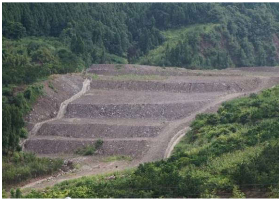
6#弃渣场恢复情况 (K59+600 右侧)
