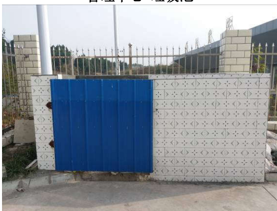
贾家收费站 垃圾池
