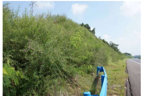
k78+500 挖方边坡植被防护
