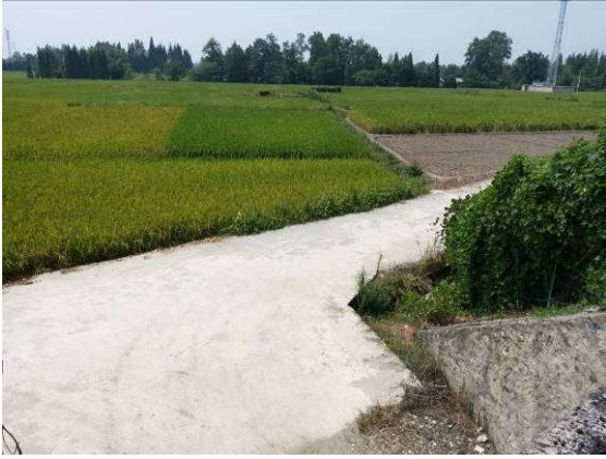
K0+000 施工便道
