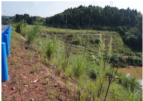
8#弃渣场恢复情况 (K63+300 左侧)
