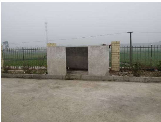
濛阳收费站 垃圾池
