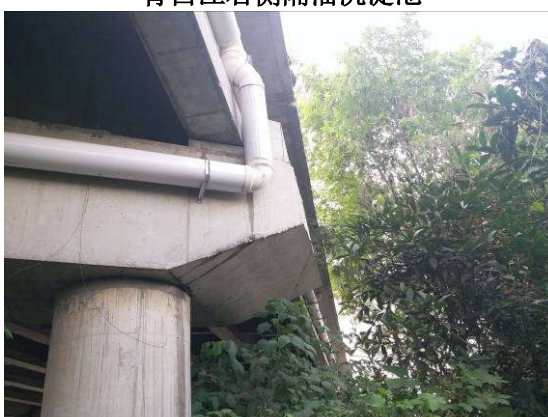
毗河大桥径流收集管道
