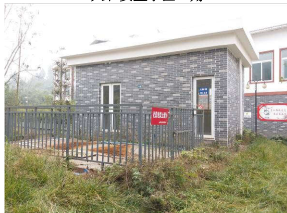
人和安置小区污水处理设施
