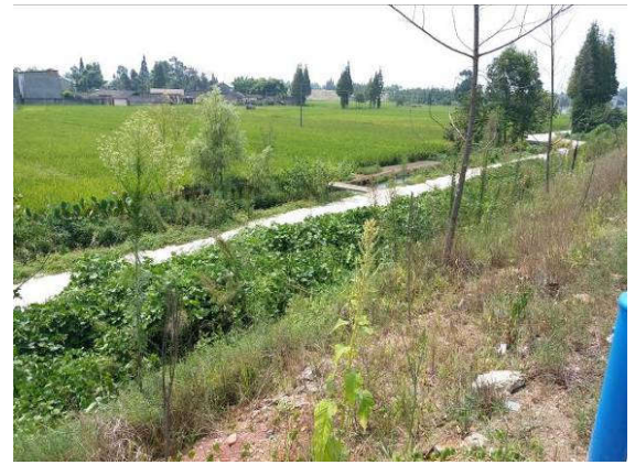
K8+600 施工便道
