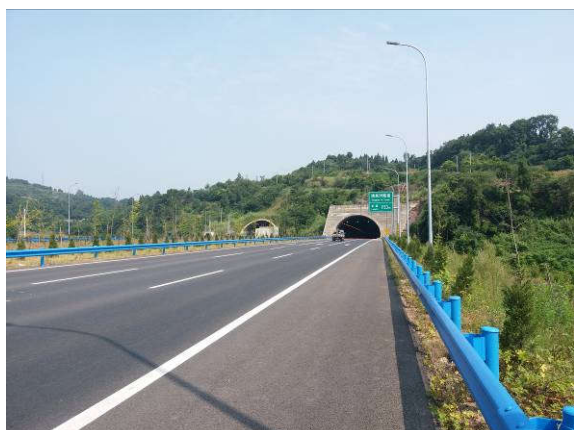
清泉 1#隧道制梁场地
