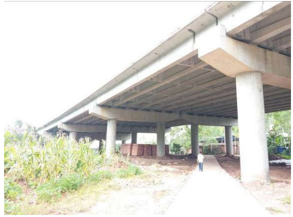
黎家沟大桥施工便道
