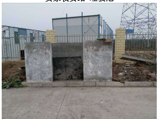
金堂收费站 垃圾池
