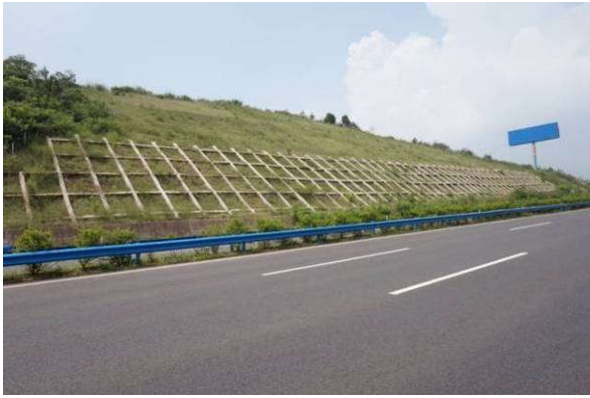
锚杆框架梁护坡
