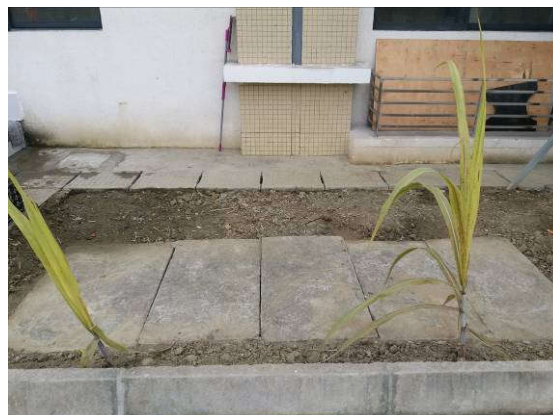
同善收费站食堂隔油池
