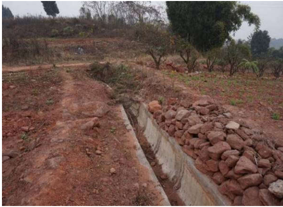
16#弃渣场排水沟
