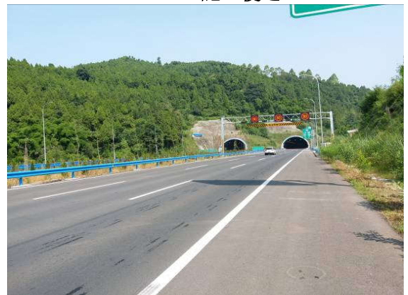
人和隧道制梁场地
