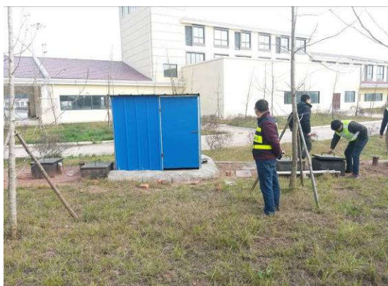
龙泉湖服务区一体化污水处理装置
