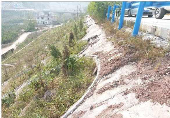
下边坡拱形骨架护坡
