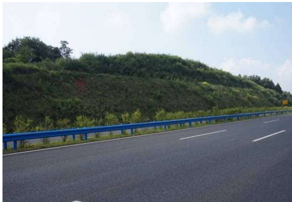
K75+800 挖方边坡植被防护
