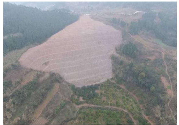
7#弃渣场恢复情况 (K60+600 左侧)
