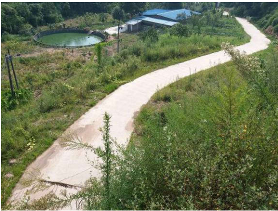
清泉 1#隧道施工便道
