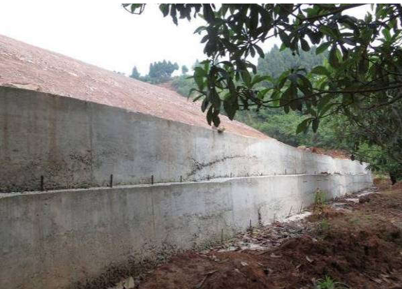
7#弃渣场坡脚挡渣墙
