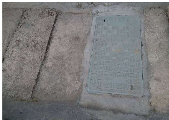
濛阳收费站食堂隔油池
