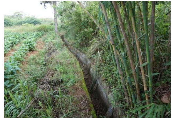
14#弃渣场排水沟
