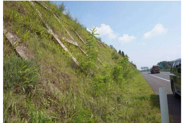
k76+000 挖方边坡植被+砣组合防护
