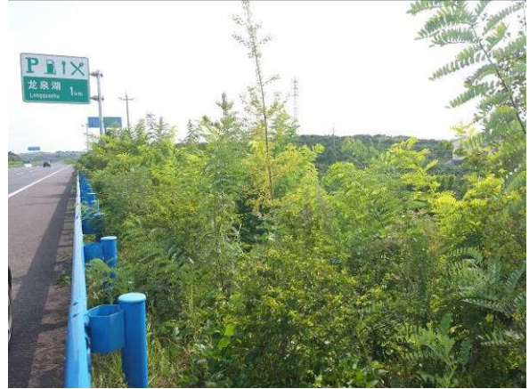
下边坡植被防护
