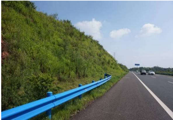
k73+000 挖方边坡植被防护
